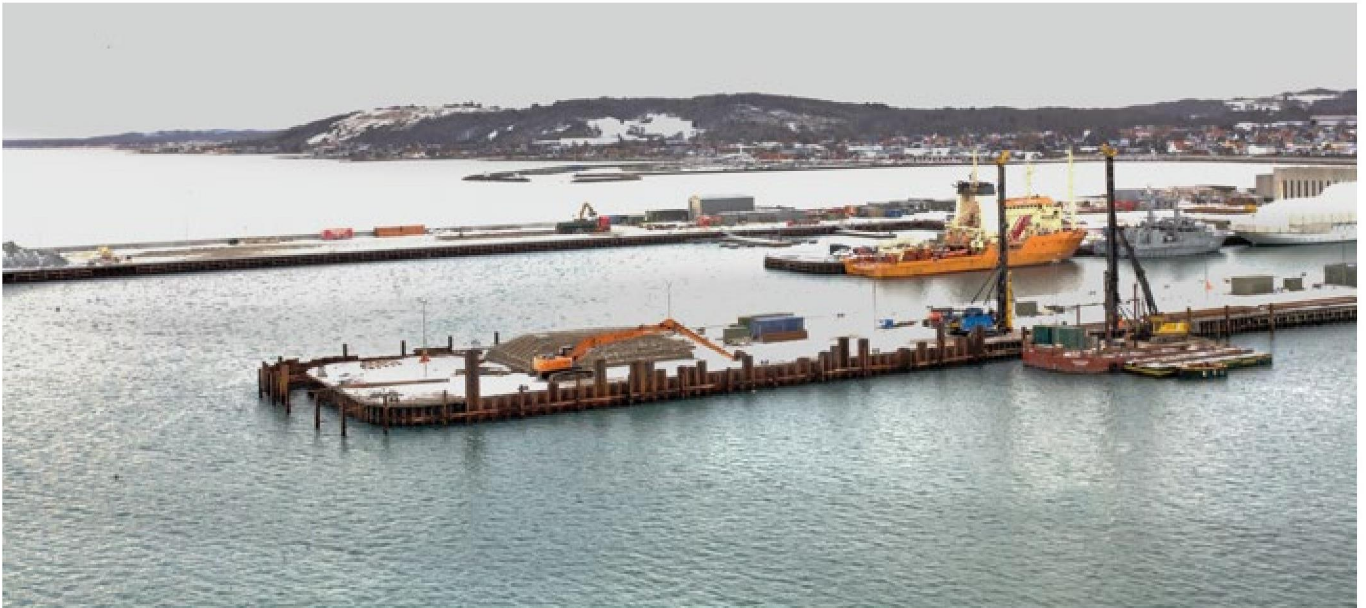
▲ Det omfattende anlægsarbejde på Flådestation Frederikshavn begynder nu at sætte sit præg på den nordjyske flådestation.
