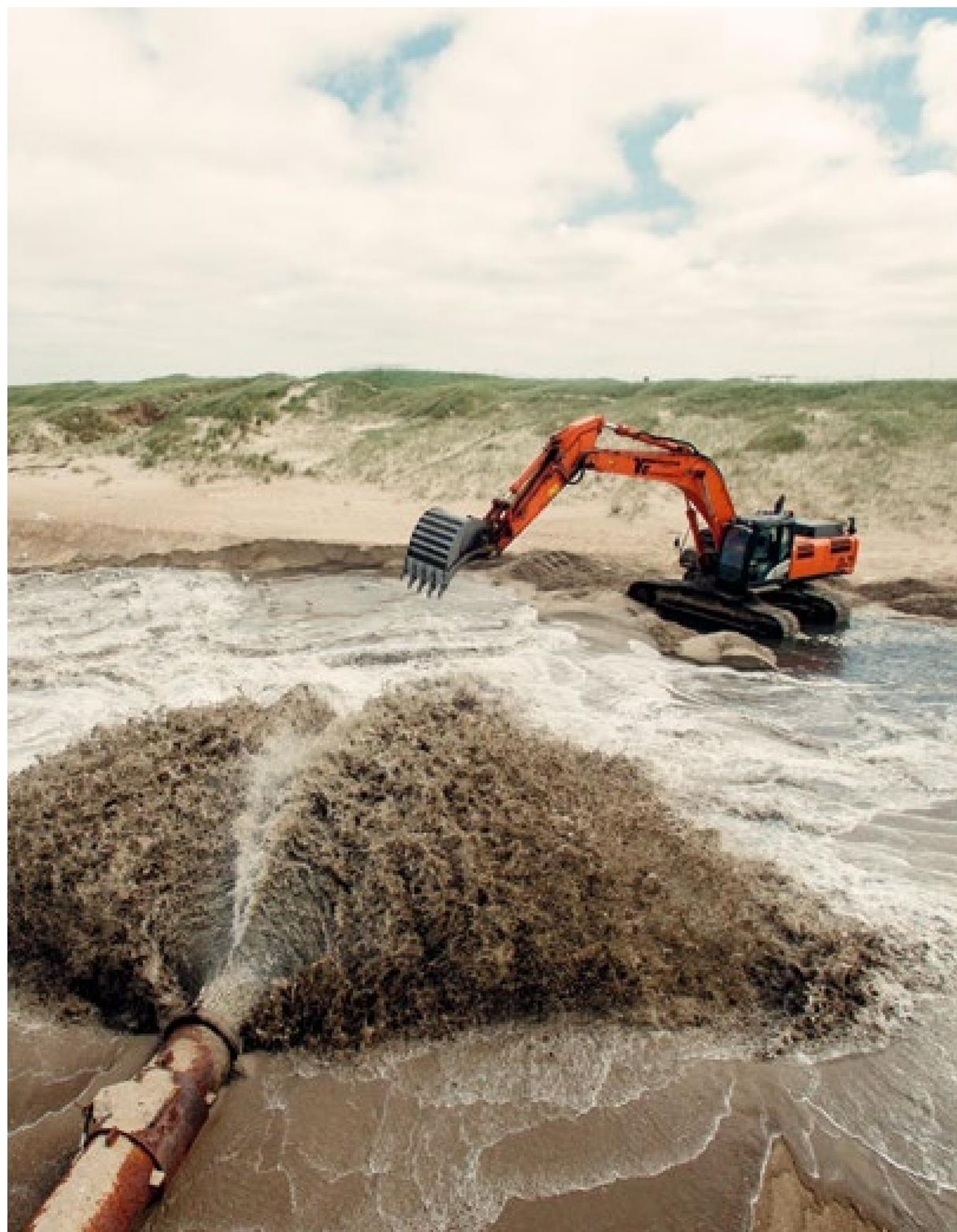
▲ Modtagelse af sand til kystsikring ved den jyske vestkyst.
